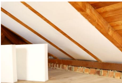
Wärmedämmung z. B. klassische Dachdämmung
